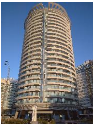
Figura 9. “Art Tower”, fotografía de un detalle de la fachada del edificio, 14/8/2020 (Federico Sequeira).
